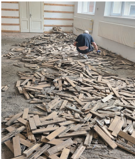
Odstranění starých parket bylo rychlé
