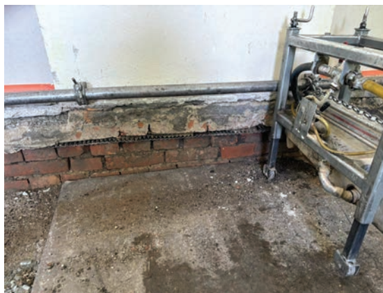
Zatloukání izolačních desek
