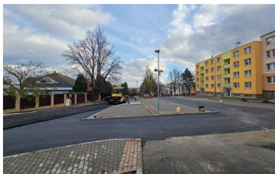
Pokládka živice na parkovišti ul. Dobrovského
