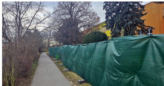
Přípravné práce u chodníku do školy
