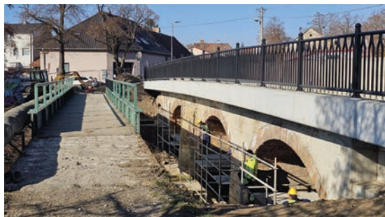
Rekonstruovaný most se starou lávkou
