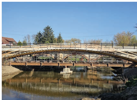
Stavba nové lávky pro pěší
