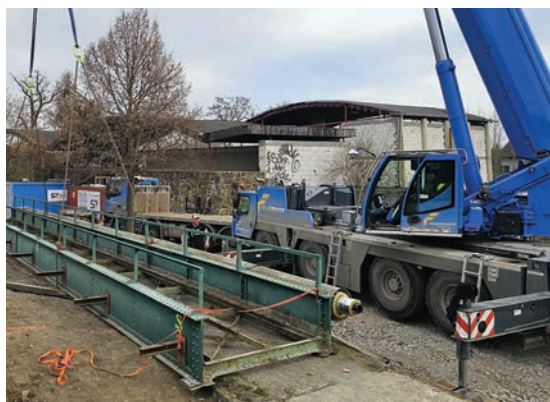
Demontáž staré lávky
