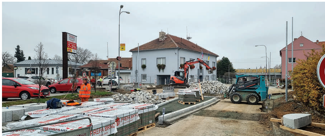
Náročná stavba spěje k závěru
