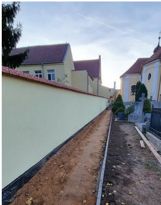
Opravená zeď na hřbitově
