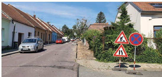
Stavební práce v ulici Havlíčkova
