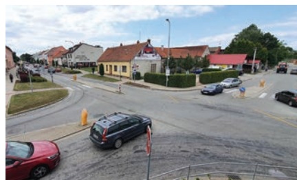
Křižovatka před rekonstrukcí
