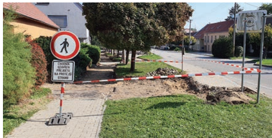
Stavební práce, chodník na Městečku
