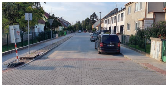
Nové chodníky v ulici Husova směrem k základní škole
