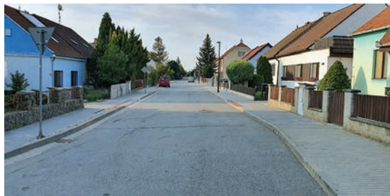
Nové chodníky v ulici Vrázova
