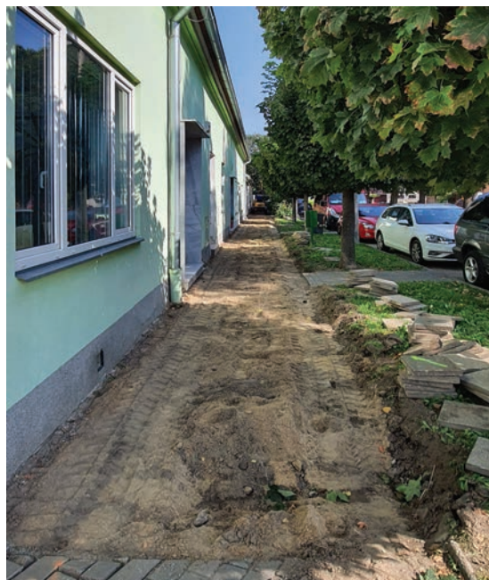
Stavební práce, chodník k Račce
