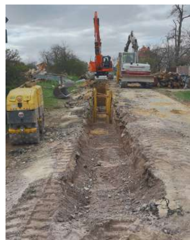
Práce na výstavbě kanalizace v Bezkově
