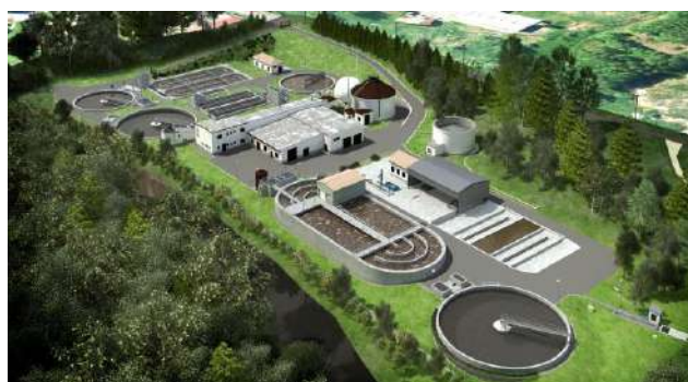
Stav ČOV Žďár nad Sázavou po rekonstrukci
