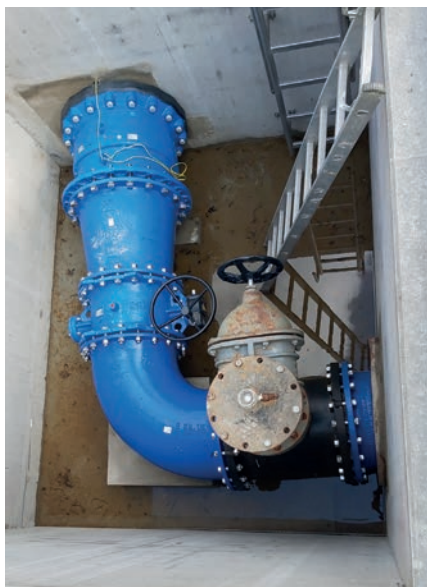
Stavba paralelního potrubí zabezpečuje bezporuchové dodávky surové vody do ÚV Mostišťe
