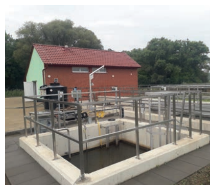
Nová čistírna odpadních vod leží na východním okraji městyse Troskotovice
