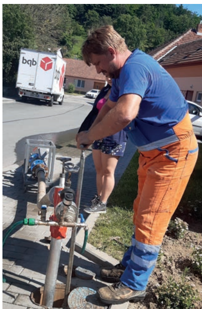
Proplachování vodovodní sítě patří ve VAS k pravidelné údržbě
