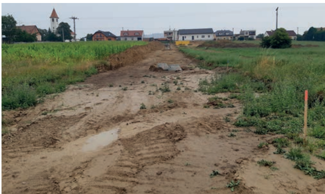
Vybudovaná dešťová a splašková kanalizace v obci Jezeřany – Horní Loučky
